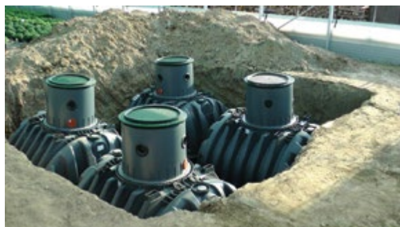
földbe süllyesztett víztartályok telepítése
